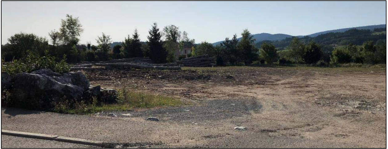
Vues sur les équipements de la zone et sur une plateforme aménagée utilisée pour le stockage du bois
