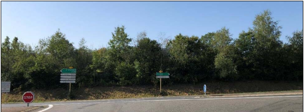
Vue sur le site au niveau de l'intersection RD1089/RD53
