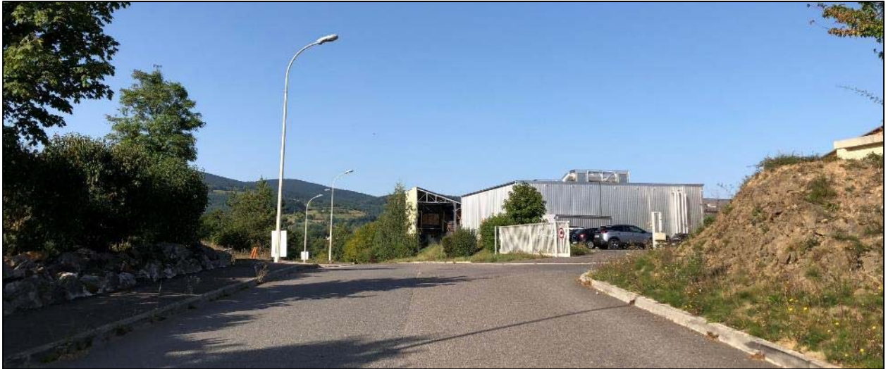
Vues sur le bâtis existants sur le site et voie de desserte
