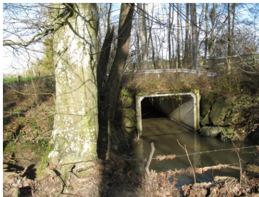
Fig. 23. Pont de Montvernay
