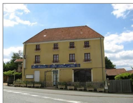
Façade commerciale – le long de la RD4
