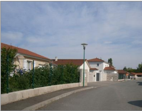
Lotissement au sud du bourg
