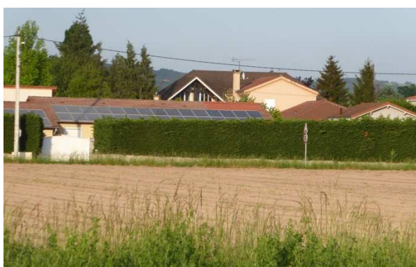
Installation solaire individuelle en toiture au Richard
