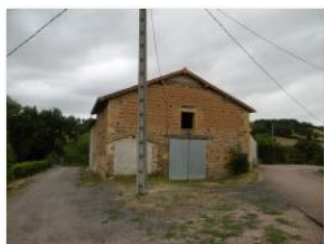
57-LES FOURS A CHAUX A1194.JPG
