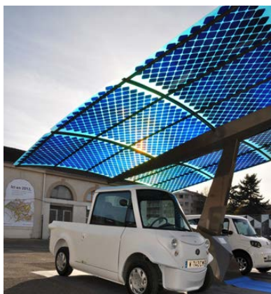
« ombrières » photovoltaïques sur un parking
