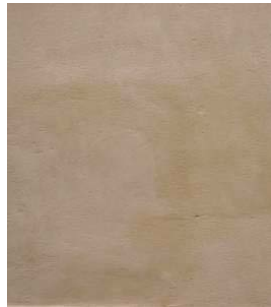
enduit lissé à la truelle
