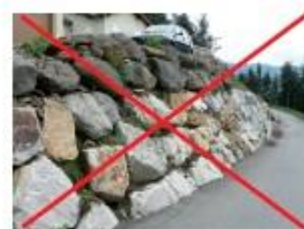
Exemple d'enrochements de type cyclopéen
