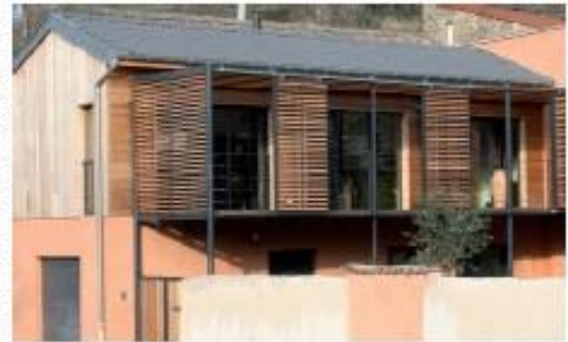
Exemple de loggia
