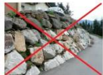
Exemple d'enrochements de type cyclopéen
