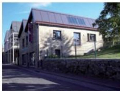
Exemple de toiture en shed
