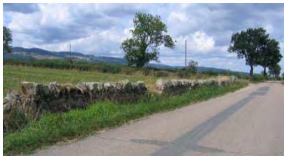
Murets en pierres le long de la VC 3
