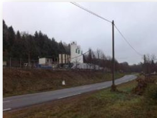
Fabrication de béton ( secteur de la Mine )
