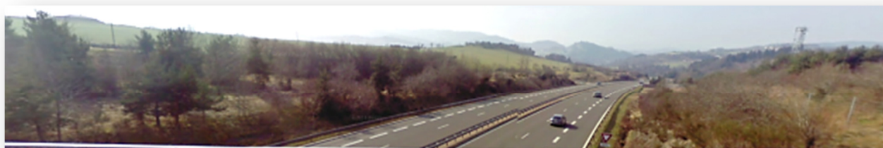
L'A89 depuis la limite communale Sud-Est avec à gauche le replat agricole
