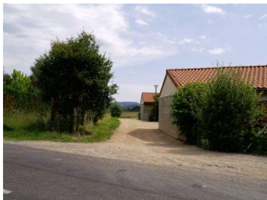
Utilisation de matériaux stabilisés pour la réalisation des chemins piétons et des abords de la voie
