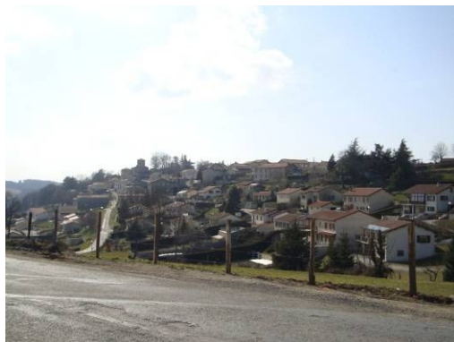
Point de vue sur Fontanès en arrivant sur la commune depuis la RD3.
