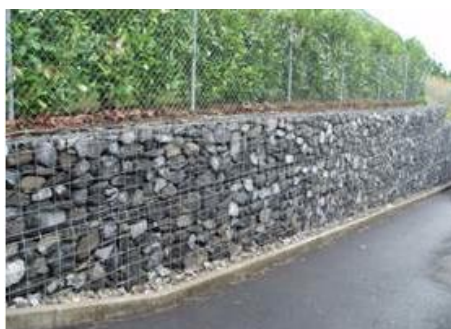
Muret en gabion
