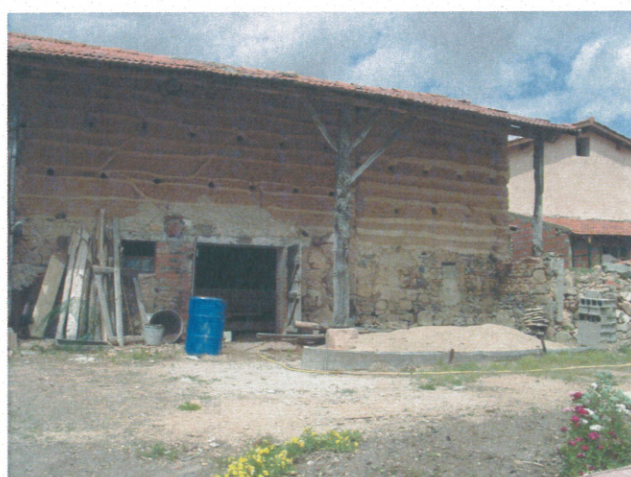
Construction en pisé
