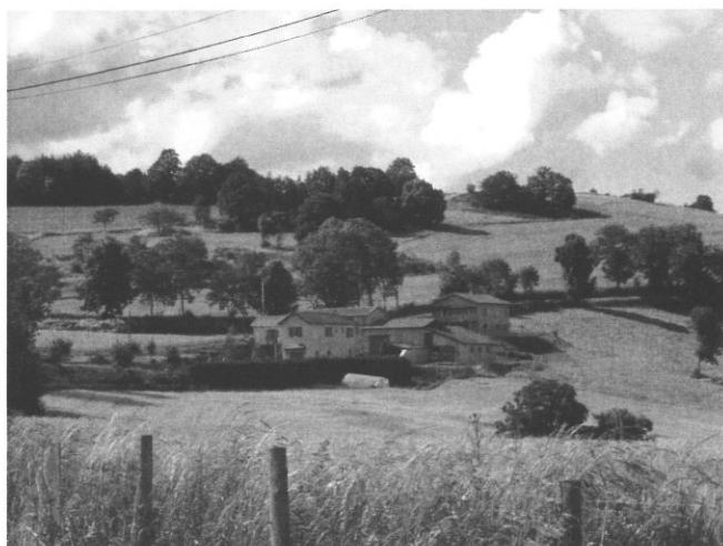
Leveaux : groupement de bâtiments ayant perdu leur fonction agricole.
