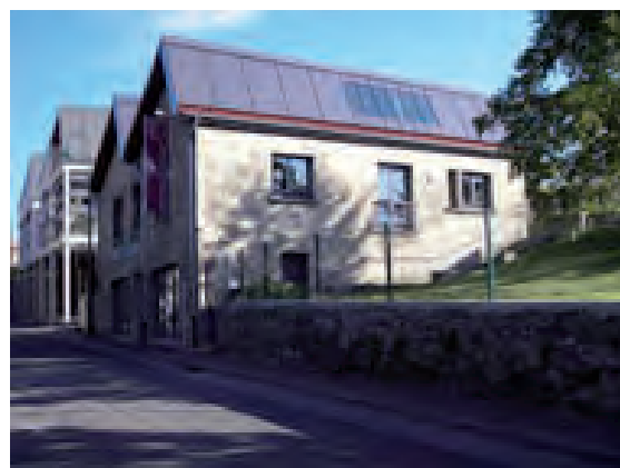
Exemple de toiture en shed
