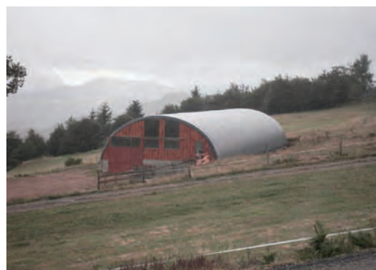
Exemple de tunnel agricole de teinte grise
