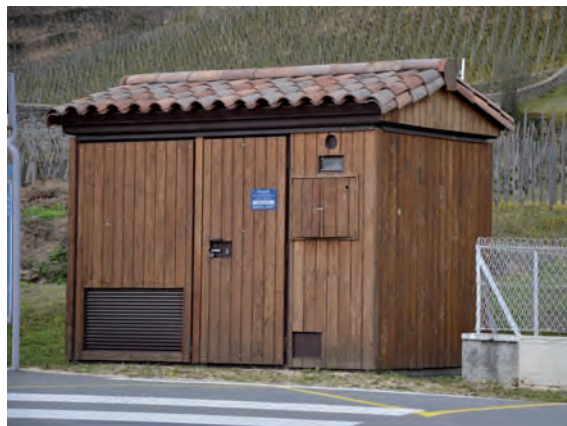
Exemple de local pour transformateur électrique
