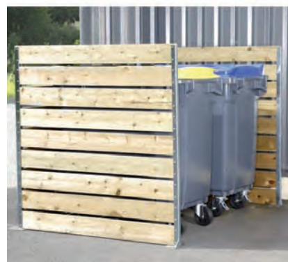
Exemple de local pour poubelles
