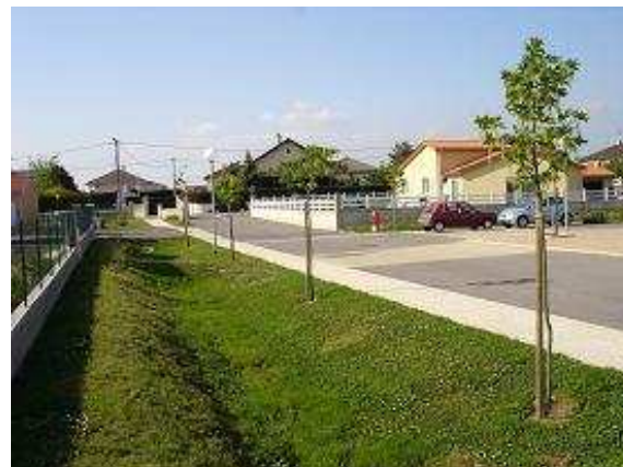
Exemple 2 : Une opération de lotissement à Veauche 42 avec une noue paysagère bordant l'espace piétons.
