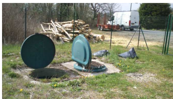
Extérieur PR1 – Grand Val – Eaux usées
