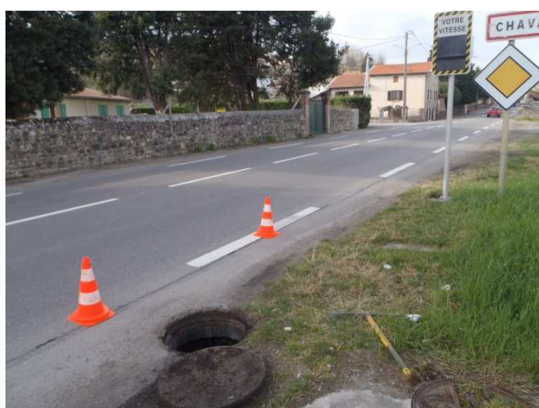
Extérieur DO7 – Amont PR Grande Gorge
