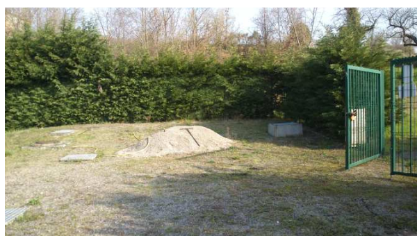
Emplacement du décanteur digesteur du Grand Embuent
