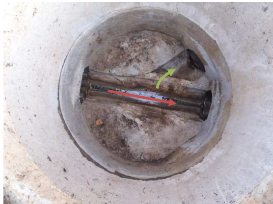
Intérieur DO8 – Amont STEP
