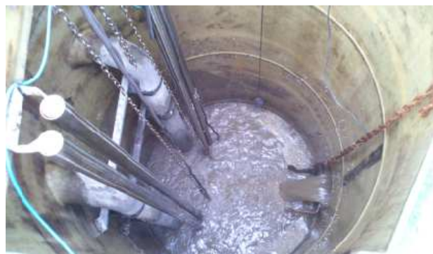
Vue intérieure – PR Jassoux Aval
