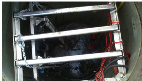
Intérieur PR3 – Supin – Eaux usées
