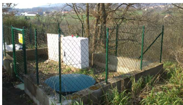
Vue extérieure – PR Grand Embuent
