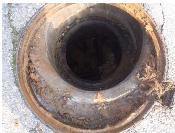
Cadre décalé – Regard n°789 – Réseau eaux usées – Chemin des Vessettes
