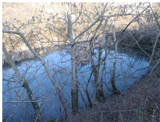
Bassin de lagunage avec arbres
