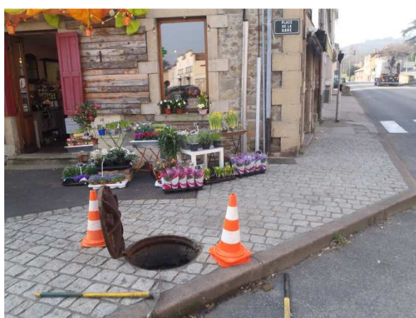
Extérieur DO3 – Place de la Gare
