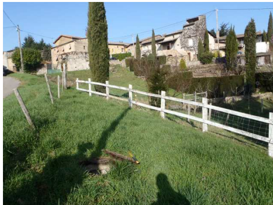
Extérieur DO8 – Amont STEP
