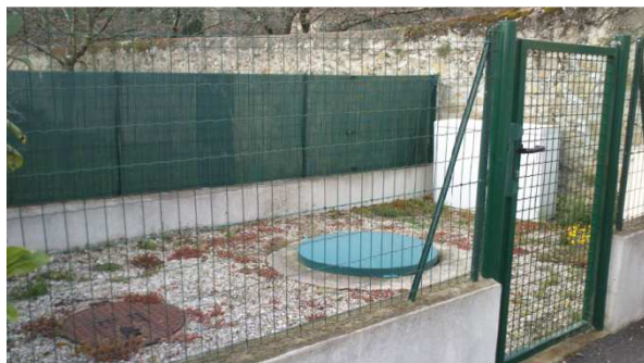
Extérieur PR3 – Supin – Eaux usées
