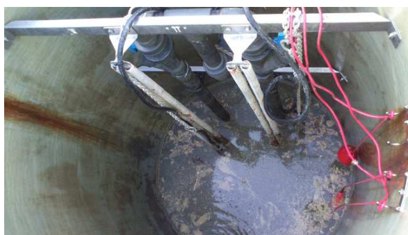
Vue intérieure – PR Grand Embuent
