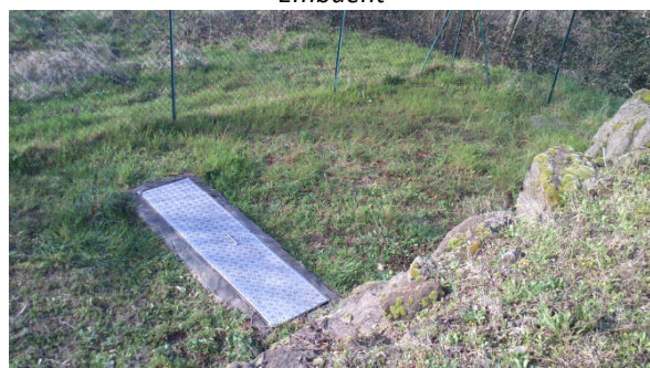
Canal de sortie
