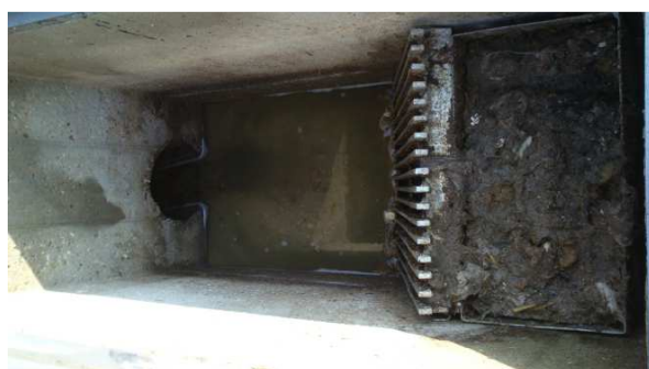
Canal d'entrée et Dégrillage
