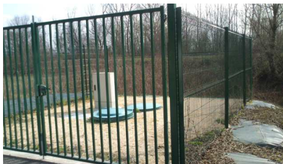
Extérieur PR7 – Chanson – Eaux usées
