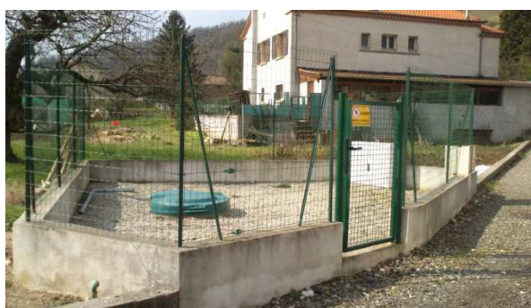
Extérieur PR5 – Marin – Eaux usées
