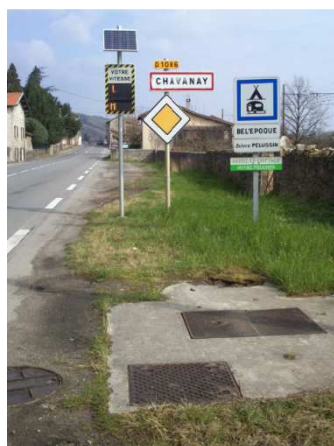
Extérieur PR8 - Grande Gorge – Eaux usées
