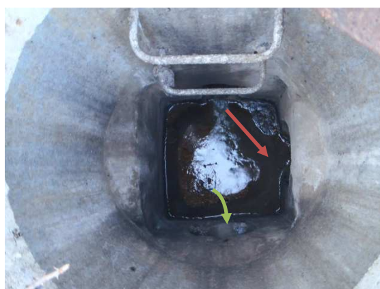
Intérieur DO9 – Amont STEP
