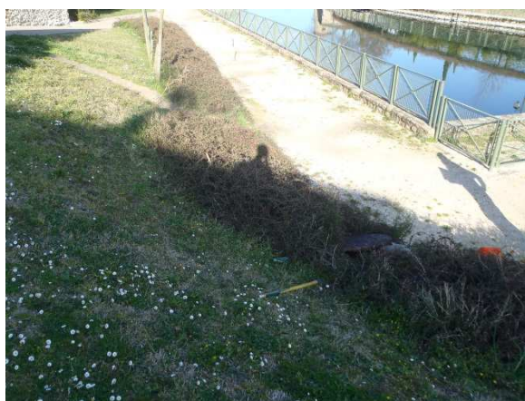
Cadre non scellé – Regard n°664 – Réseau eaux usées – Plan d'eau
