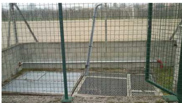
Vue extérieure – PR Stade
