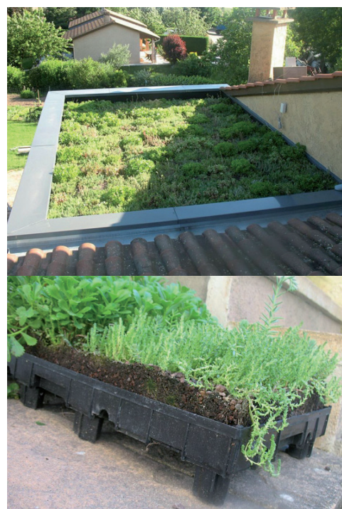
Exemple de toiture-terrasse végétalisée et bacs pré-cultivés
