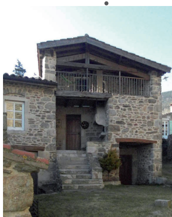
Exemple de débord de toiture
