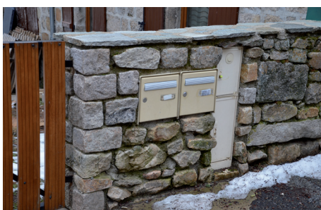
Exemple d'intégration d'éléments techniques
