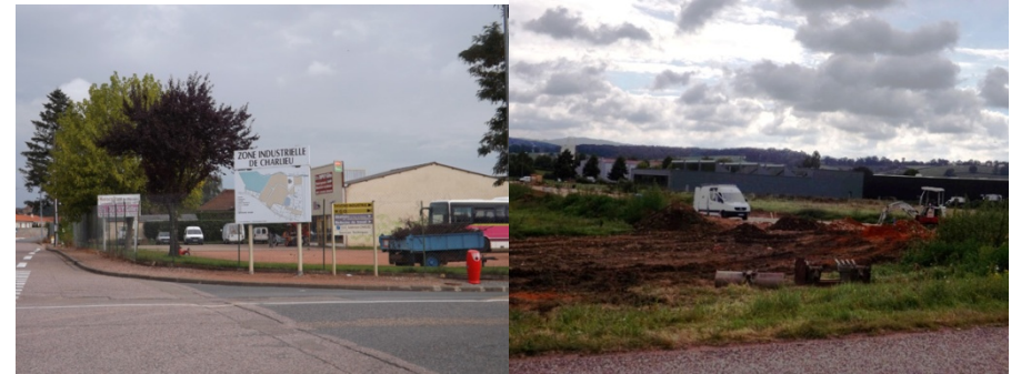
La zone d'activité du Brionnais, et les travaux d'extension
