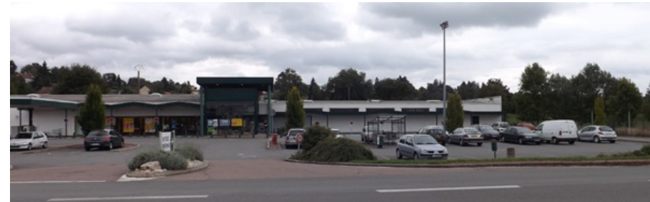
Secteur du Pont de pierre, le long de la RD4
