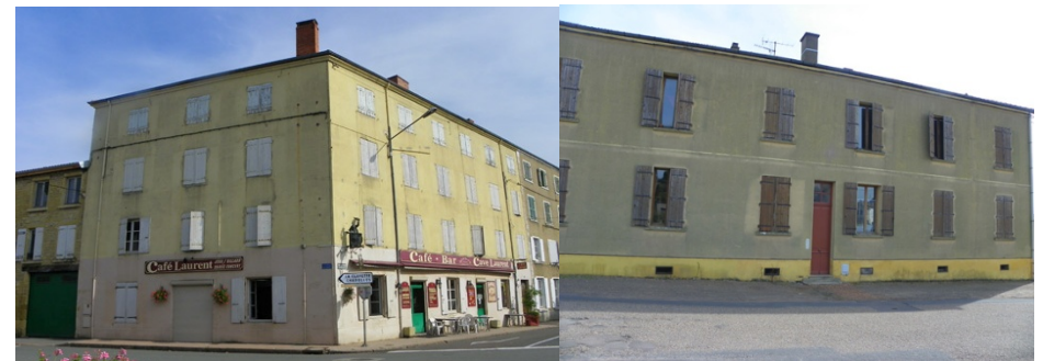
Boulevard Louis Valorge, et chemin des Pensemollés
