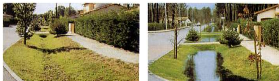
Exemples de traitement des eaux pluviales sous forme de noue ou de
