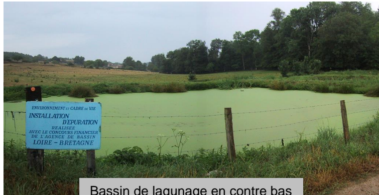
Bassin de lagunage en contre bas du bourg
