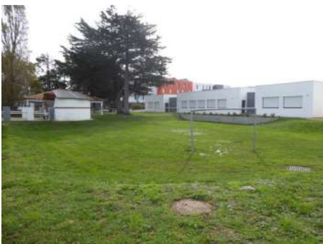
Bassin de récupération des eaux de pluie
