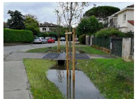
Noue paysagère après orage
