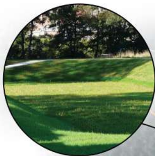
Bassin de gestion des eaux pluviales
