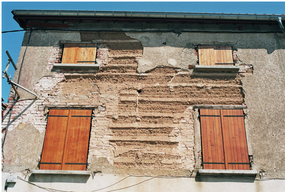
Cas le plus fréquent de murs réalisés en pisé (Le Bourg)
