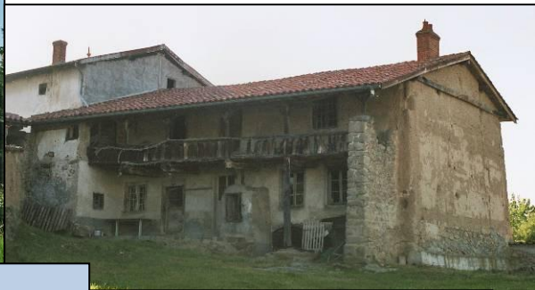
Ancienne ferme à galerie à Albieux
