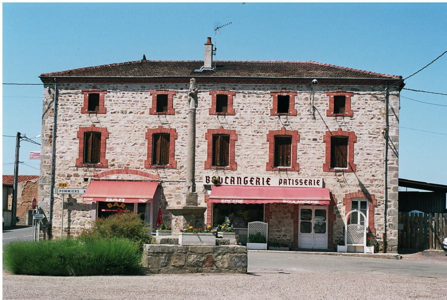
Maison en pierre avec toiture à 4 pans en tuiles mécaniques losangées (Le Bourg)
