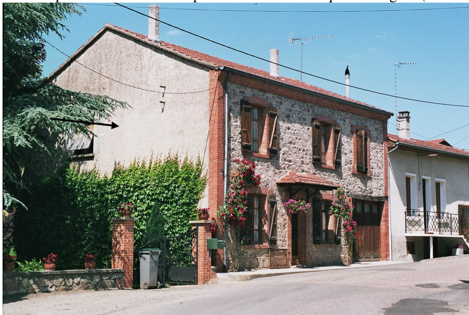
Maison en pierre avec toiture à 2 pans en tuiles mécaniques losangées (Le Bourg)
