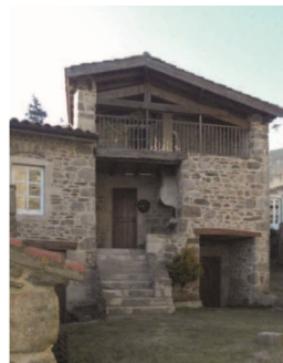
Exemple de débord de toiture
