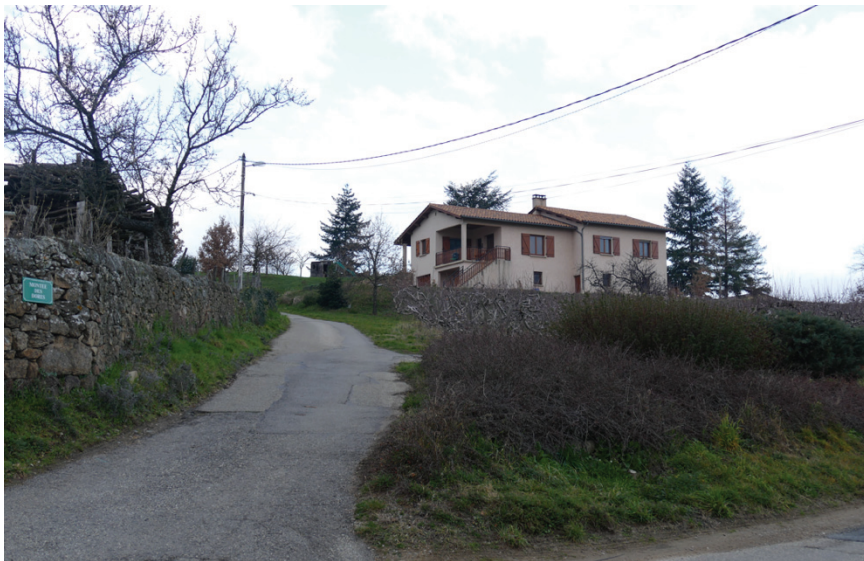
Constructions pavillonnaires le long de la rue des Dorés
