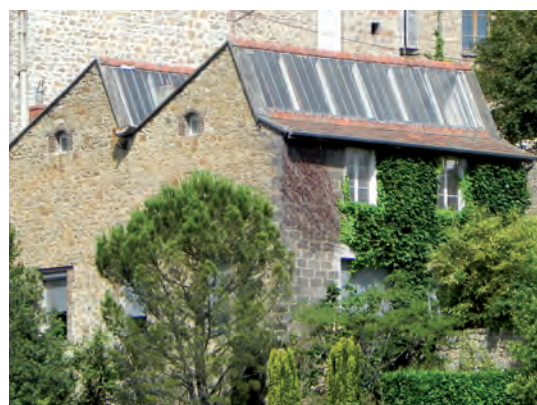
Exemple de toiture en Shed
