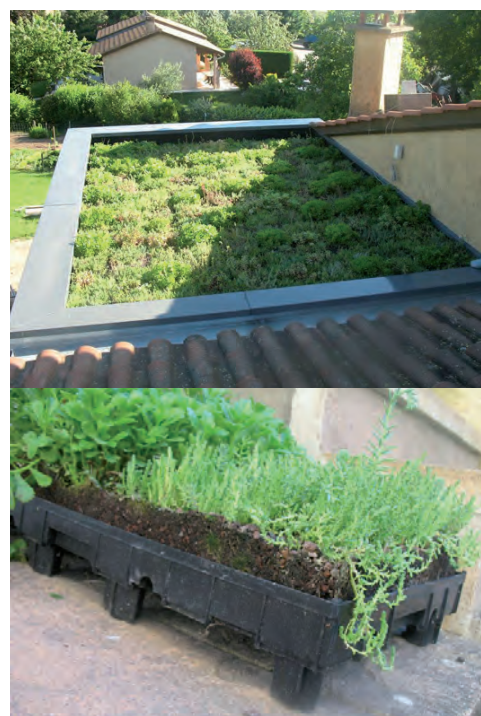
Exemple de toiture-terrasse végétalisée et bacs pré-cultivés
