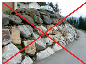
Exemple d'enrochements de type cyclopéen
