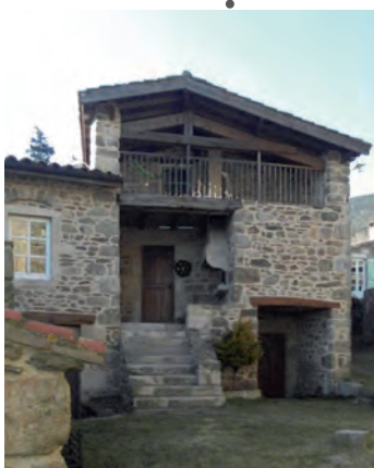
Exemple de débord de toiture
