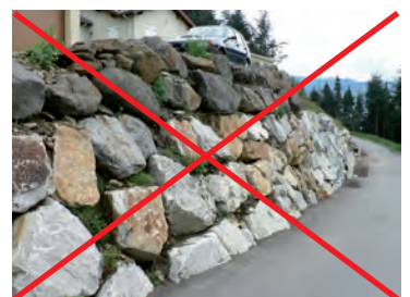
Exemple d'enrochements de type cyclopéen
