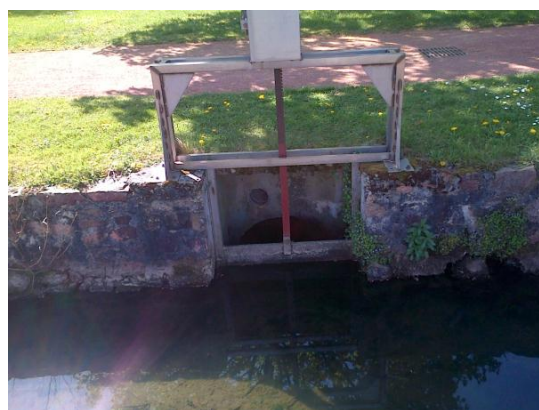
Bief en rive gauche du Renaison : ouvrage sous la chaussée, et vanne existante (retour au Renaison)
