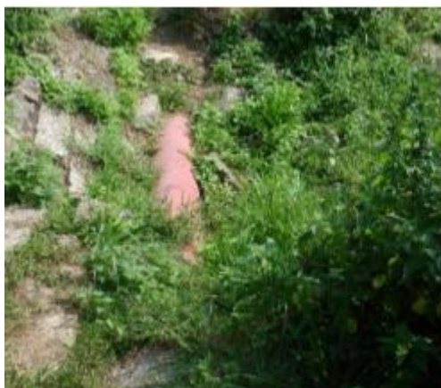
Renaison, collecteur d'eaux usées, secteur R4 (Artelia – 2012)
