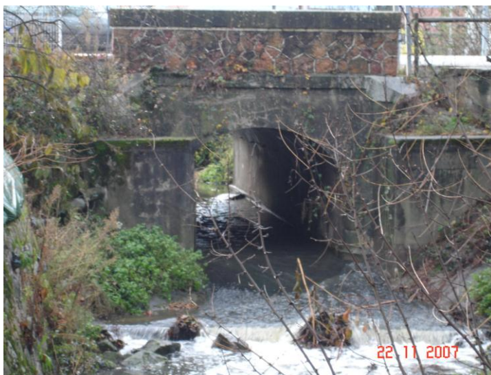
Ouvrage vu de l'aval
