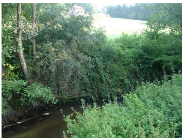
1 er coude à l'aval de la RD 35 (perré)
