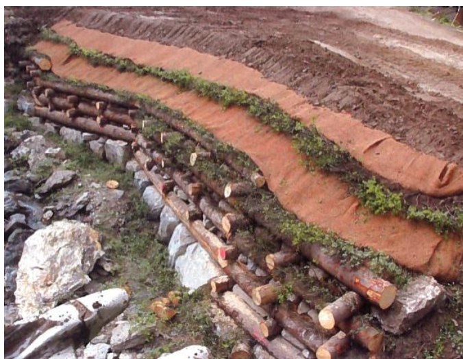
Caissons végétalisés, en fin de chantier, sur le site de Bens à Saint-Hugon, 2011 3
