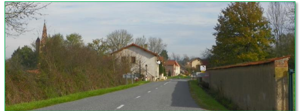
L'entrée Ouest par la RD 4, marquée par un front de chaque côté de la voie composée d'une haie d'un côté et d'un muret
