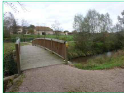
Cheminement reliant la rue des Convers aux Duffourtes
