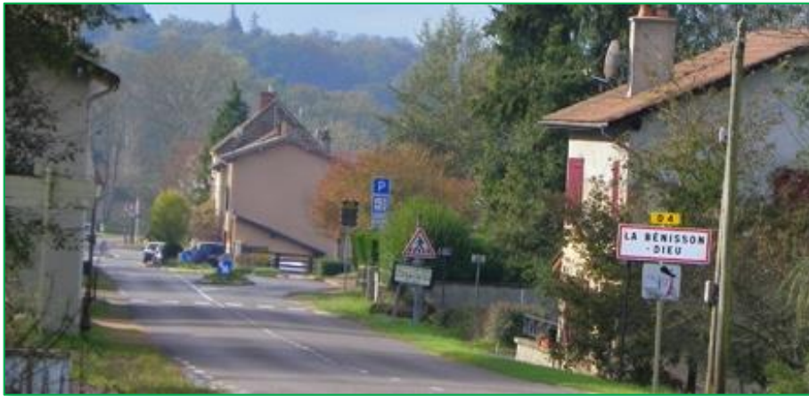
Entrée Est par la RD 4 : Front bâti interrompu afin de permettre une ouverture visuelle sur l'Abbaye
