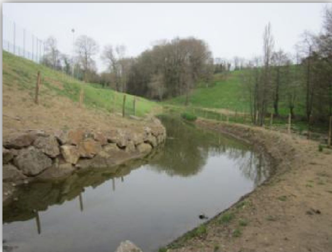
Figure 30 : Fossé de rétention situé en contrebas du complexe sportif
