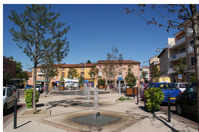
Restructuration urbaine des espaces du centre d'Andrézieux (place du Forez)
