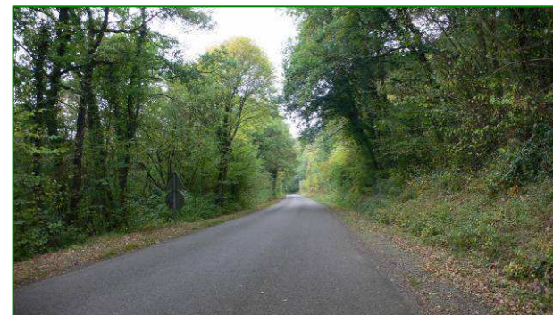
Route du coteau, entre la Saulnerie et la Rochette
