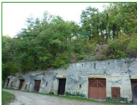
Entrées de caves au niveau de « La Rochette »
