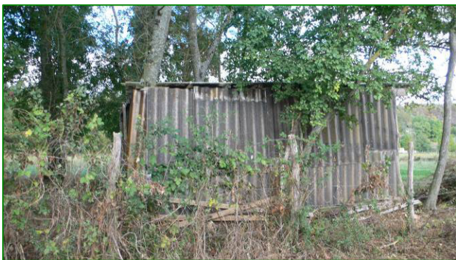
Abri pour l'élevage intégré au bosquet, sur le secteur Le Rocher, caractérisé par l'utilisation de matériaux de récupération
