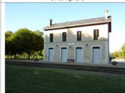
Ancienne gare au niveau du lieu-dit « La Rochette »
