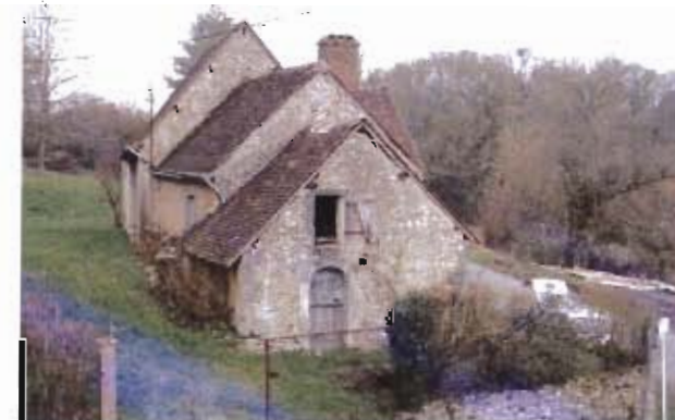
Construction à réhabiliter
