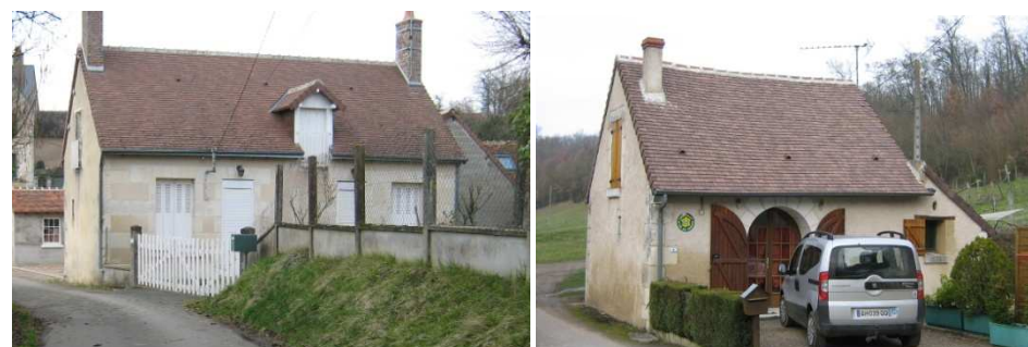
Toiture à deux pans en tuiles plates récentes
