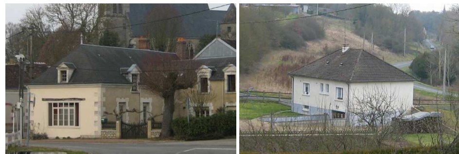
Toiture à 4 pans en ardoise à gauche et en tuile mécanique à droite
