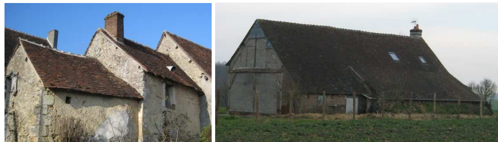
Toiture à deux pans en tuile plate
