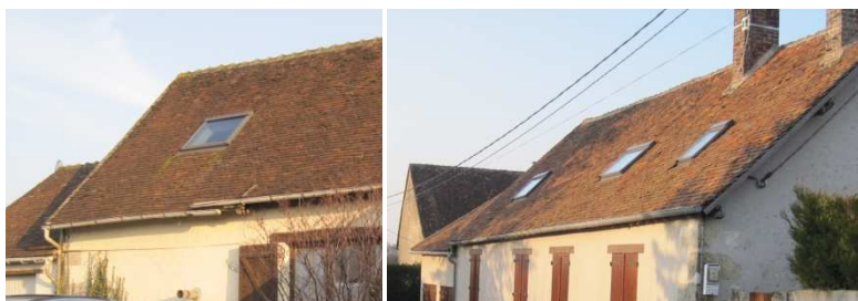
Ouvertures dans la toiture
