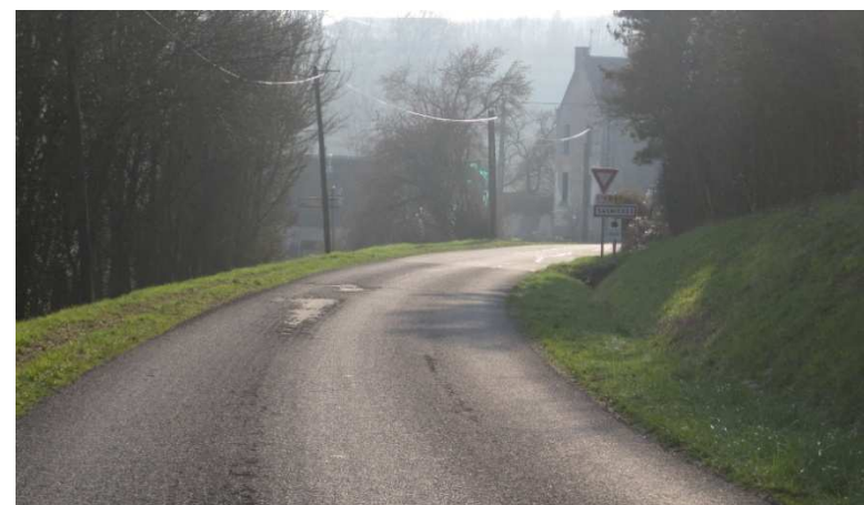
Vue D, entrée Est
