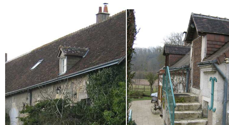
Lucarnes dans la toiture
