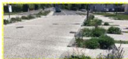
Exemple d'un plateau piéton sécurisé (Source : Le Bourget du Lac)
