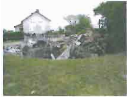
Figure 5 : destruction complète d'un pavillon à la suite d'un effondrement liés à un phénomène karstique (source : DDT 45)
