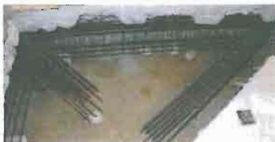
Figure 33 : Reprise en sous-œuvre par coulage d'une longrine BA sous les fondations existantes
