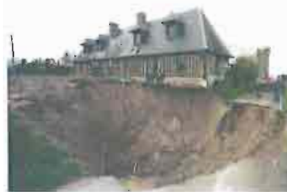
Figure 7 : effondrement d'une cavité souterraine à proximité d'une habitation en Normandie – une victime (CEREMA)
