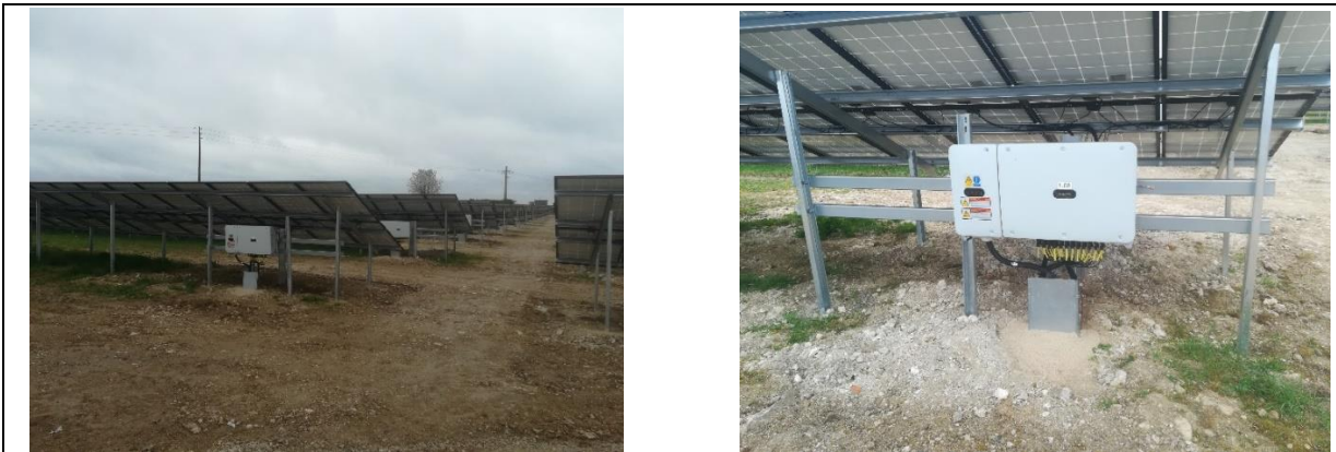
Vues sur un onduleur et câble enfoui dans le sol (Source TotalEnergies)
