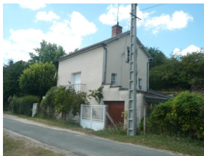
9. La Pêcherie : maison éclusière sur le canal de Berry
