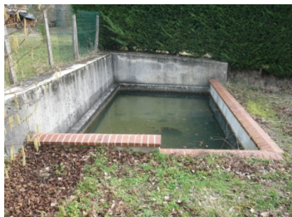
4. Villedieu - rue de la Plage : lavoir
