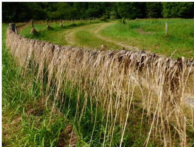
Des traces encore très présentes de la dernière crue
