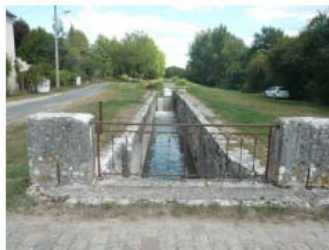
8. La Pêcherie : écluse du canal de Berry
