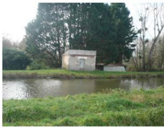
5. Villedieu - canal de Berry : abri de pontier
