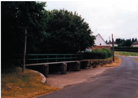
Passerelle en amont du village
