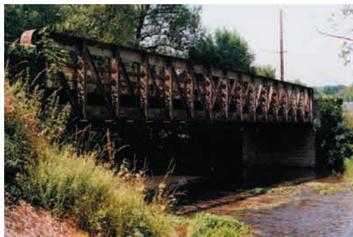
Gué et passerelle à Courtozé
