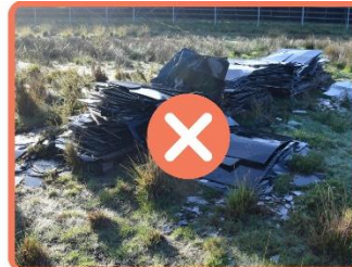
Exemple de stockage incorrect des modules
