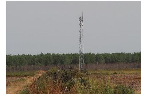
Antenne relais en limite Ouest du site d'étude
