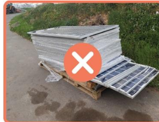
Exemple de stockage incorrect des modules
