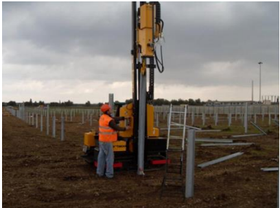
Installation de pieux battus Source : TOTAL ENERGIES
