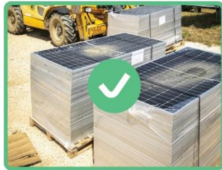
Exemple de stockage correct des modules
