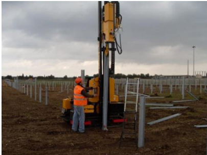
Installation de pieux battus Source : TOTAL ENERGIES
