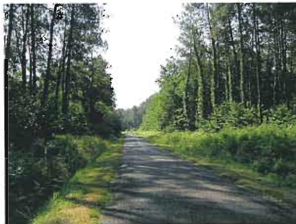
« Vue couloir » sur la RD 382
