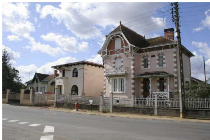
Un patrimoine bâti à préserver
