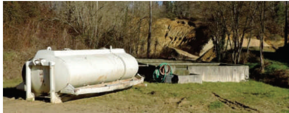
Figure 36 : Citerne et bassin de décantation près du pont bascule
