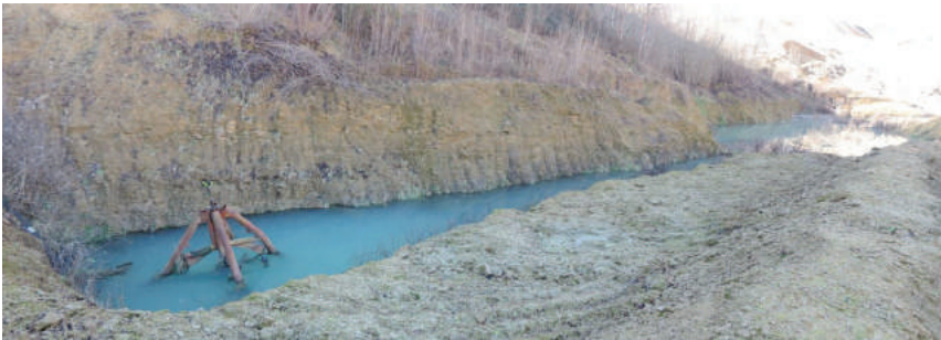
Pompe en bout de bassin de collecte
