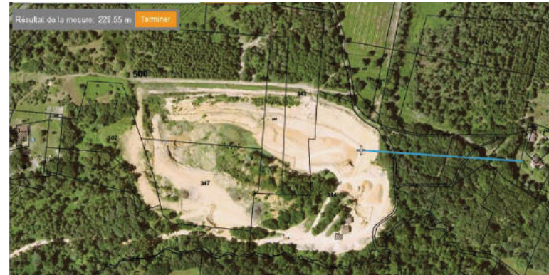
Figure 13 : Distance mesurée entre la zone de travail la plus proche et la maison « Maymie »
