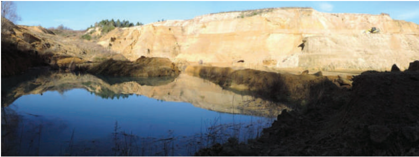
Bassin de collecte des eaux de ruissellement et de nappe
