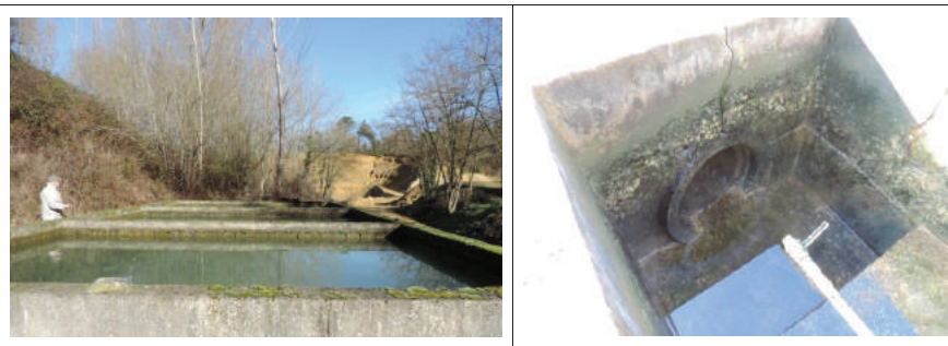
Bassins de décantation et ouvrage d'évacuation vers le Caillau
