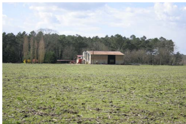
Des constructions agricoles à fort impact paysager dans le paysage ouvert
