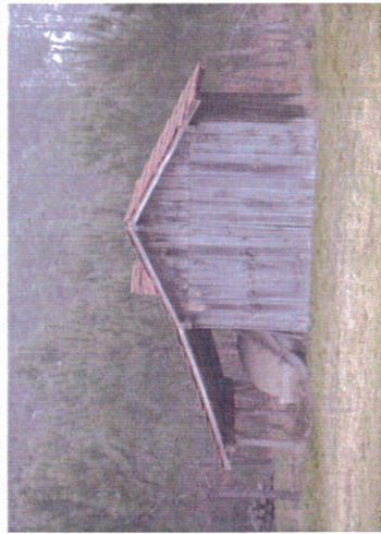
granges avec toit à deux longs-pans asymétriques dont l'un forme auvent
