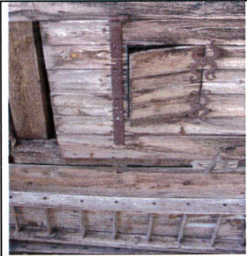
Vantail de porte avec penture droite sur gond et guichet abattant. pivotant sur des
