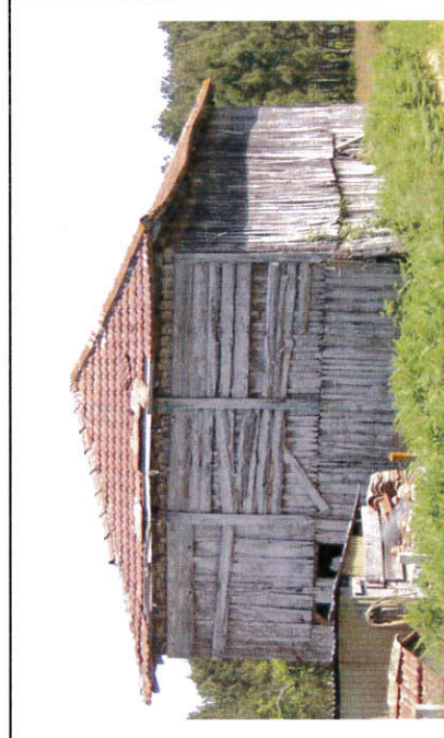
Murs exposés à l'ouest, : bardage constitué d'un double cours de planches : planches verticales avec ou sans couvre-joints et des planches horizontales en partie haute
