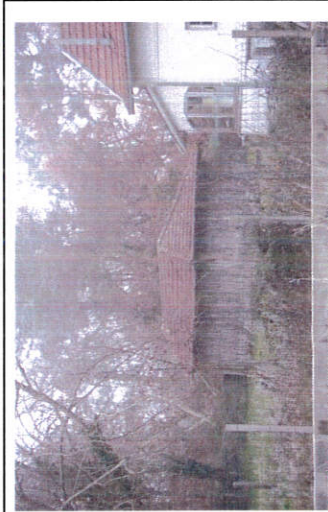
grange avec un toit à deux longs-pans et une croupe
