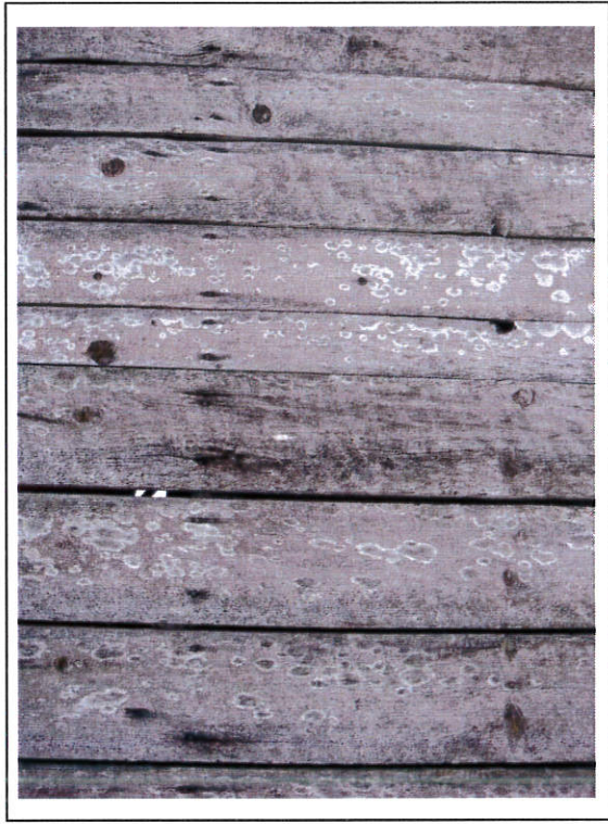
bardage sans couvre-joint
