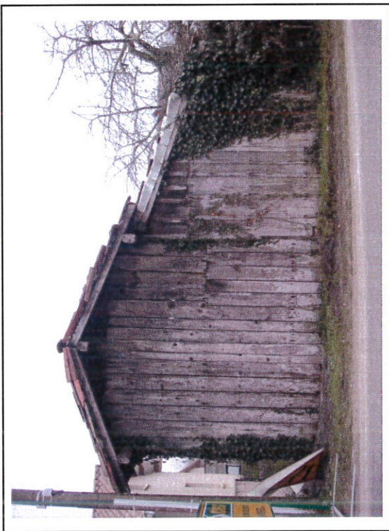
bardage sans couvre-joint
