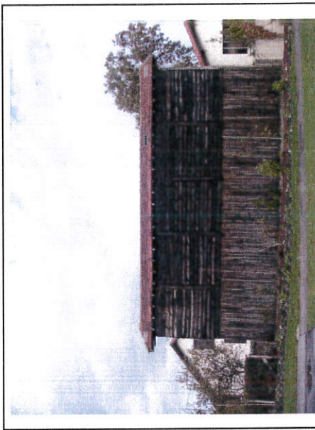
bardage passé au carbonyl
