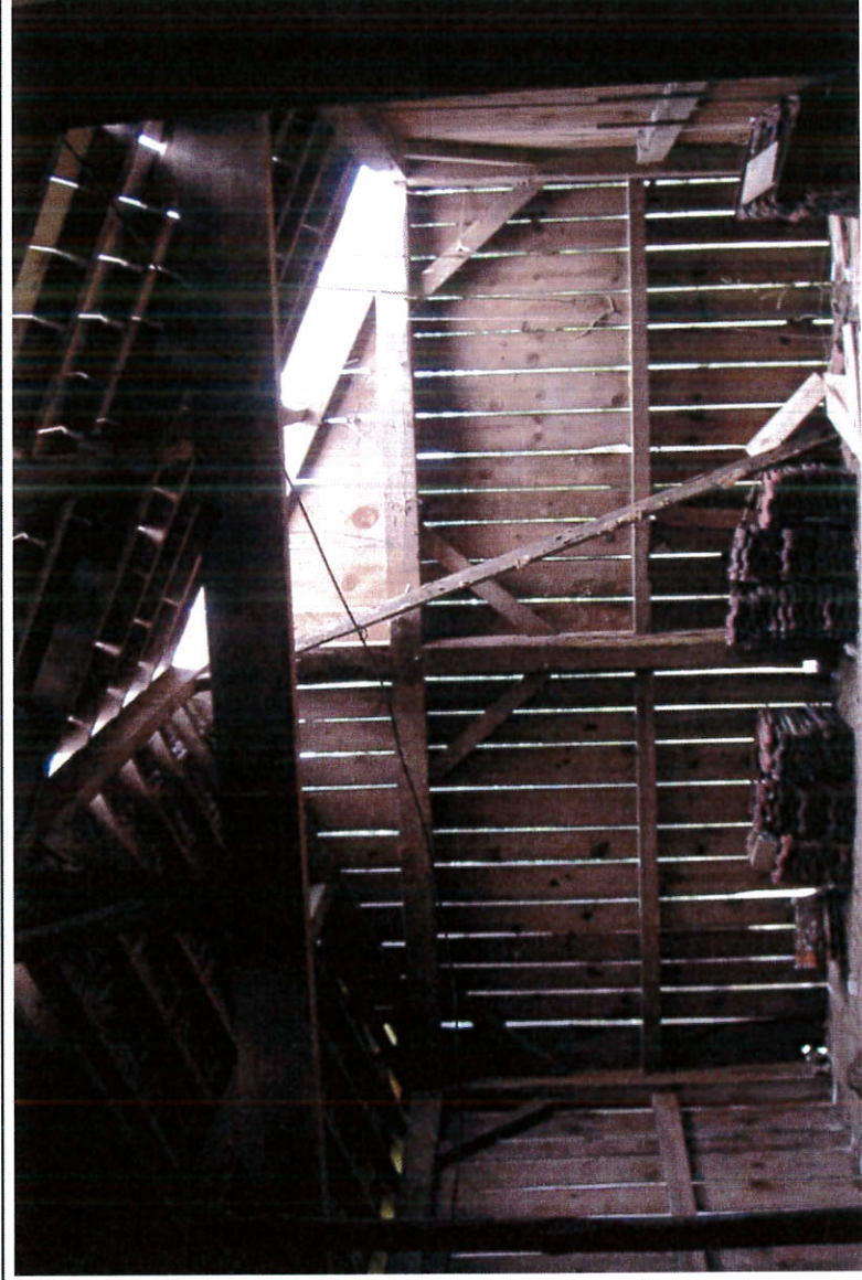
mur en charpente : vue de la structure prise de l'intérieur de la grange, au niveau supérieur, bardage en cours de réfection
