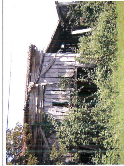
Murs exposés à l'ouest, : bardage constitué d'un double cours de planches : planches verticales avec ou sans couvre-joints et des planches horizontales en partie haute
