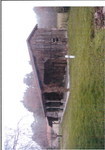
granges avec toit à deux longs-pans asymétriques dont l'un forme auvent
