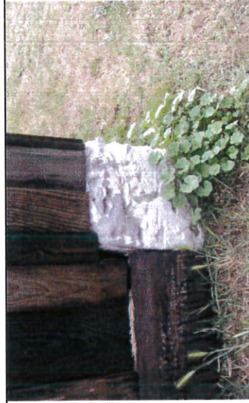
poteau sur dé en pierre (calcaire)
