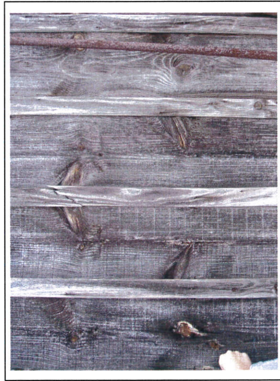
bardage avec couvre-joints
