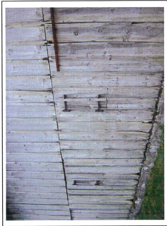
bardage avec couvre-joints
