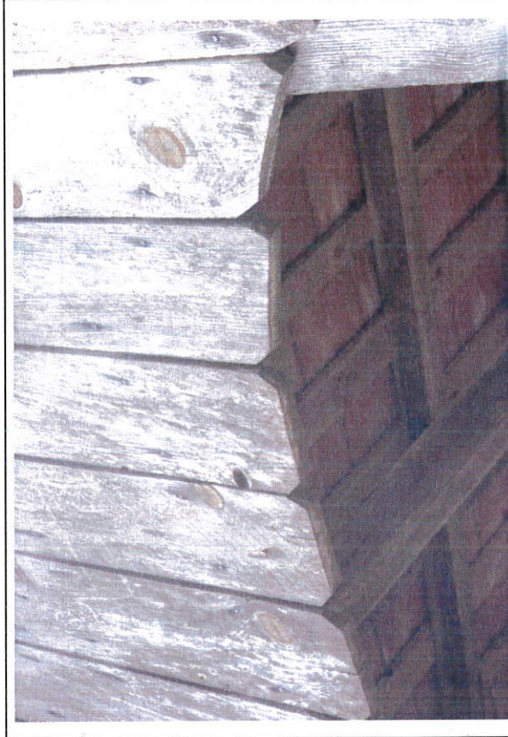
découpe du bardage sur auvent
