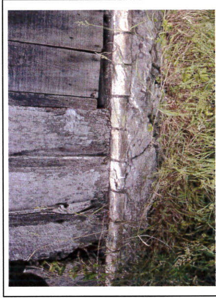
solin en moellons tout venant hourdés et enduits au mortier de chaux naturelle et sable local et chaperonné par une assise de chantignolles posées en boutisse
