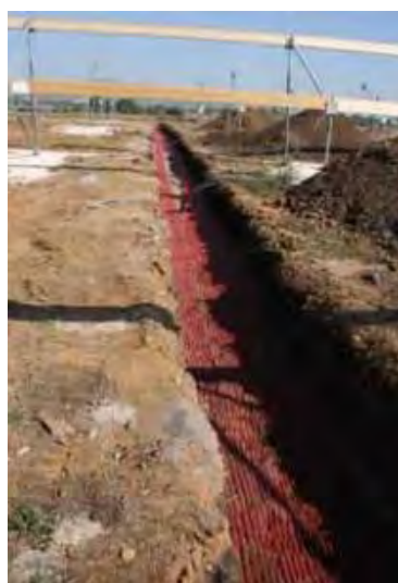
Ouverture d'une tranchée pour l'enfouissement des câbles
