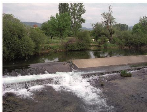
Seuil de la Cuisance en amont du pont du village.
