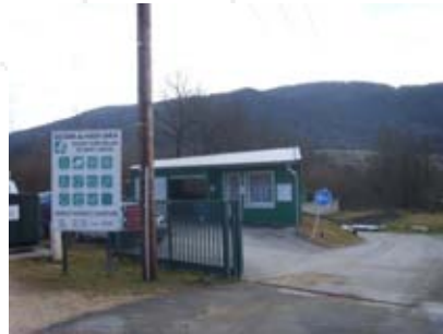
Déchetterie en contrebas de la zone industrielle Est
