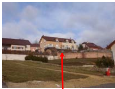
Construction récente composée d'un habitat individuel groupé : -la hauteur et le volume du bâtiment ne respecte pas la composition du tissu urbain, -l'implantation en haut d'une pente accentue son impact paysager.
