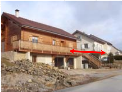
Maison ossature bois au cœur du lotissement de la Lésine : -implantation similaire aux autres constructions, -couleurs de façades qui ne s'intègre pas au sein du paysage urbain, -couleur de toiture rouge.
