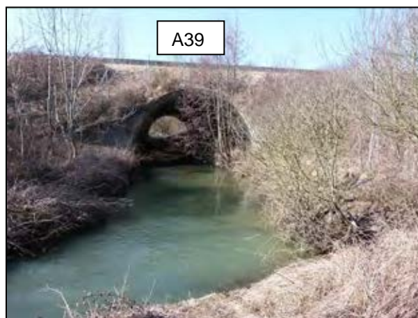
passage sous l'autoroute
