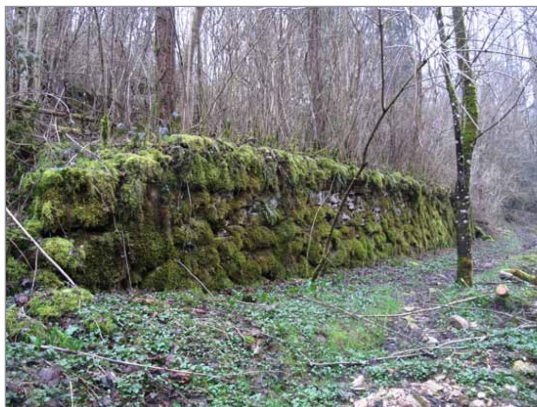
Vue 3 : Chemin épaulé et mur de soutènement. Une combinaison d'ouvrages intéressante
